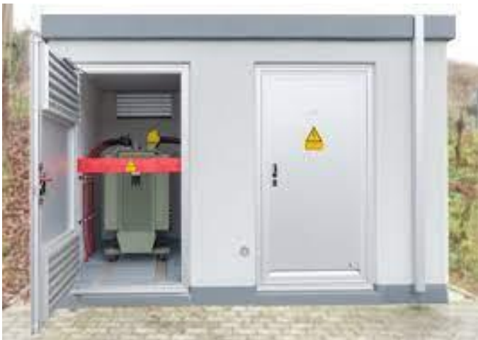
Abbildung 2: Beispiel Trafostation
